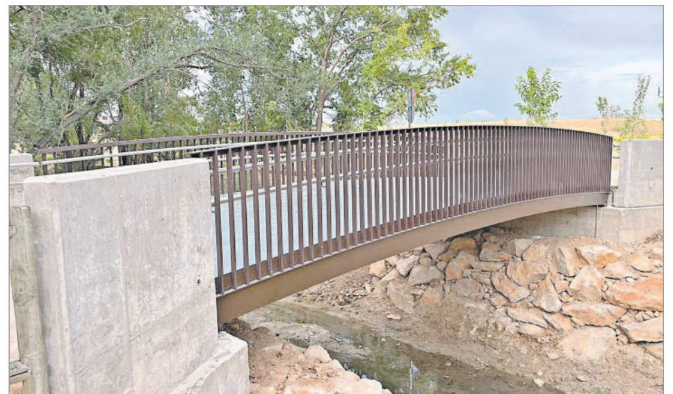
Esta nueva infraestructura favorecerá una mayor accesibilidad y conexión del barrio de El Olivar y el futuro barrio de Las Sedas con el entorno del CEIP Pablo Neruda y los barrios de IVIASA y el Chorrillo
